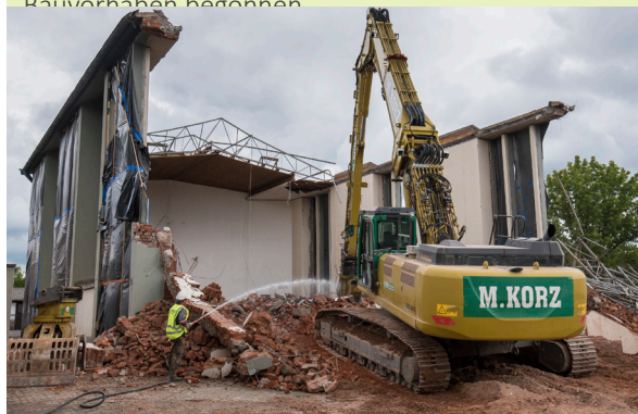
Rückbau der Kirche St. Norbert, 2021
